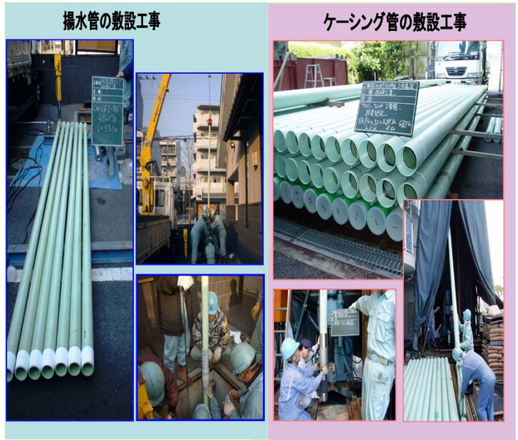
従来の腐食鋼管のFRP管に取り換え工事
